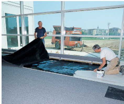
Incollaggio di pavimentazione industriale in una azienda elettronica
