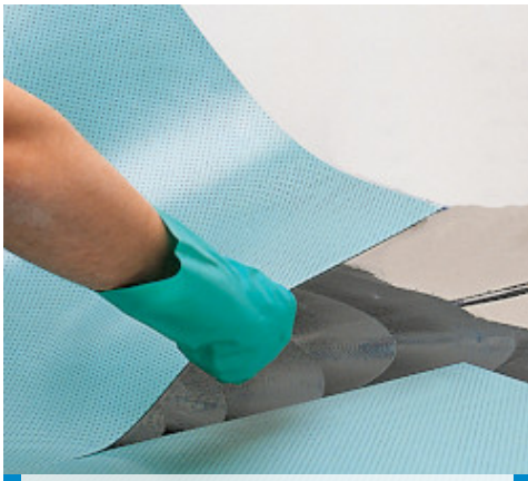
Posa di quadrotte in PVC conduttivo
