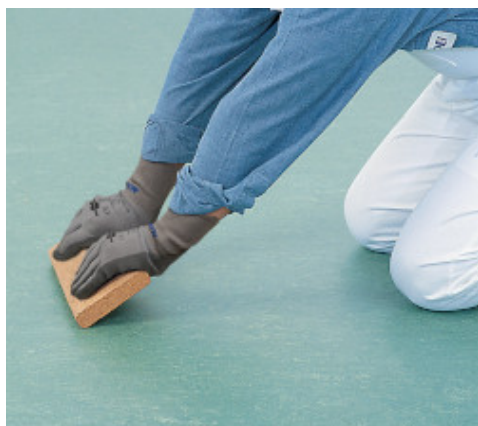
Massaggiatura del giunto di linoleum
