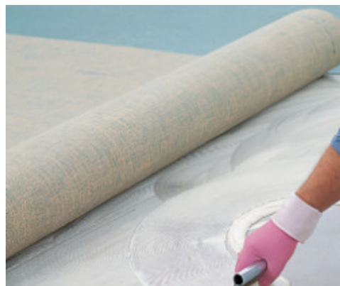
Stesura di Aquacol T per posa linoleum
